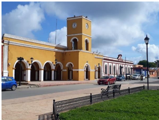
IMAGEN 20. PALACIO MUNICIPAL DE DZITBALCHÉ
