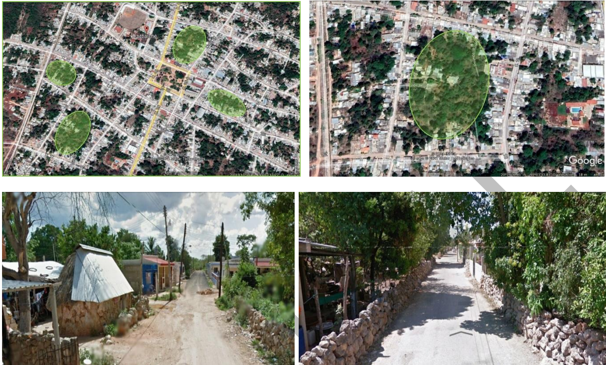
IMAGEN III.8. CARACTERÍSTICAS DE LOTES O SOLARES CON IMPORTANTE DENSIDAD DE VEGETACIÓN AL INTERIOR. DZITBALCHÉ, CAMPECHE.
